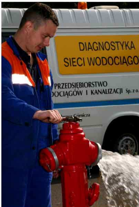
Czyszczenie sieci wodociągowej ma wiele zalet. Przede wszystkim usuwa osady, przyczyniając się do uzyskania dużej stabilności jakości wody
