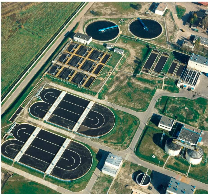
Widok Oczyszczalni Ścieków „Centrum” z lotu ptaka – przed modernizacją
