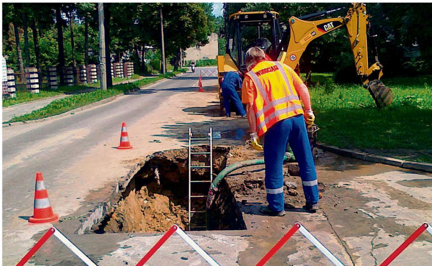
Do modernizacji wytypowano wodociągi wykazujące znaczny stopień awaryjności
