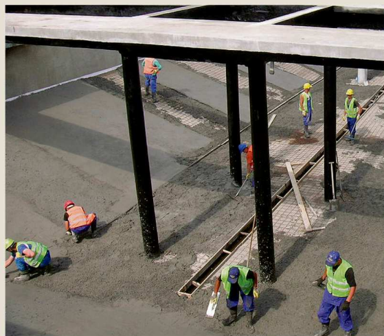
Modernizacja Oczyszczalni Ścieków Centrum – prace w komorze nityfikacji
