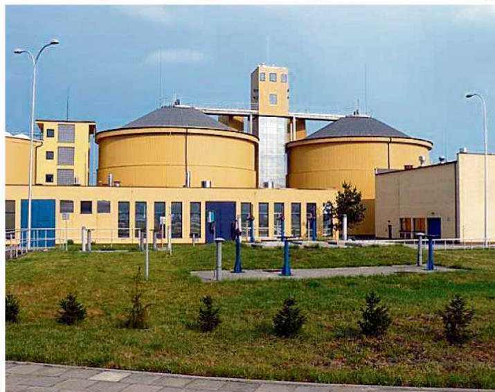
Obecny wygląd zmodernizowanych obiektów oczyszczalni
