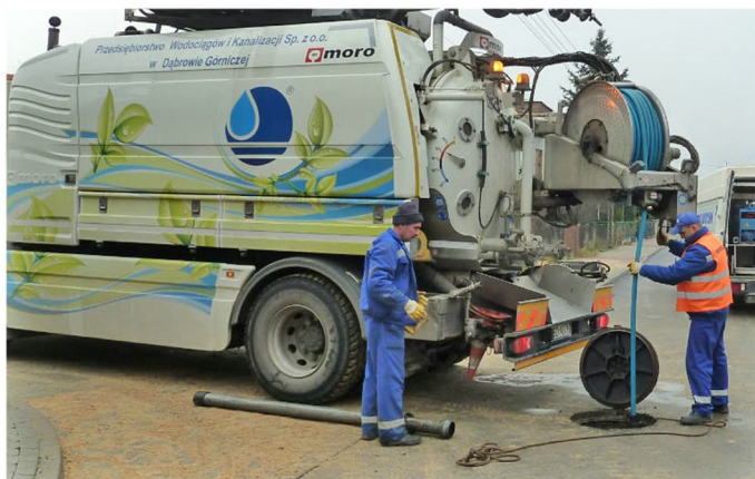
► Hydrodynamiczne czyszczenie sieci kanalizacyjnej na ul. Niemcewicza w Dąbrowie Górniczej
