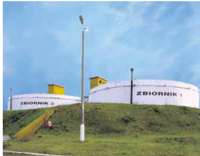
Zbiorniki wody na ujęciu wody w Ujejscu
