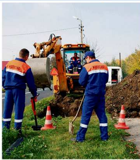
Budowa nowych wodociągów w Dąbrowie Górniczej
