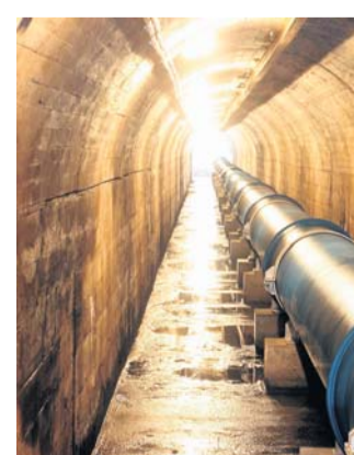
Wodociąg DN600 pod torami, Łabędy
