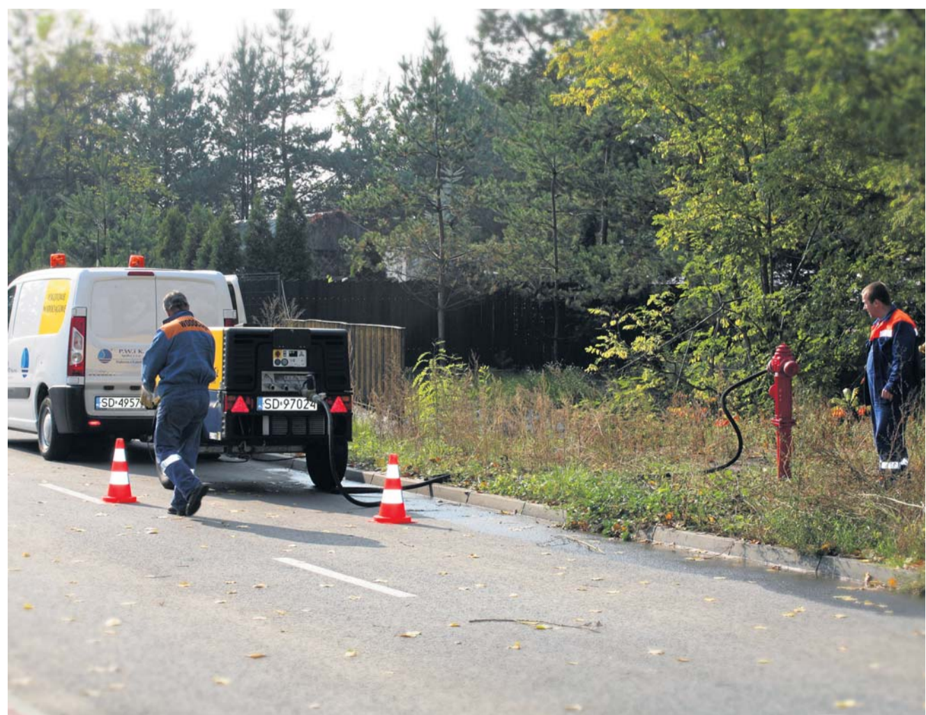
Hydropneumatyczne czyszczenie sieci wodociągowej na terenie Dąbrowy Górniczej
