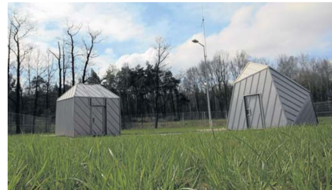
Nowoczesne studnie głębinowe wg projektu Zalewski Architecture Group. Wielokrotnie nagradzane w konkursach architektonicznych
