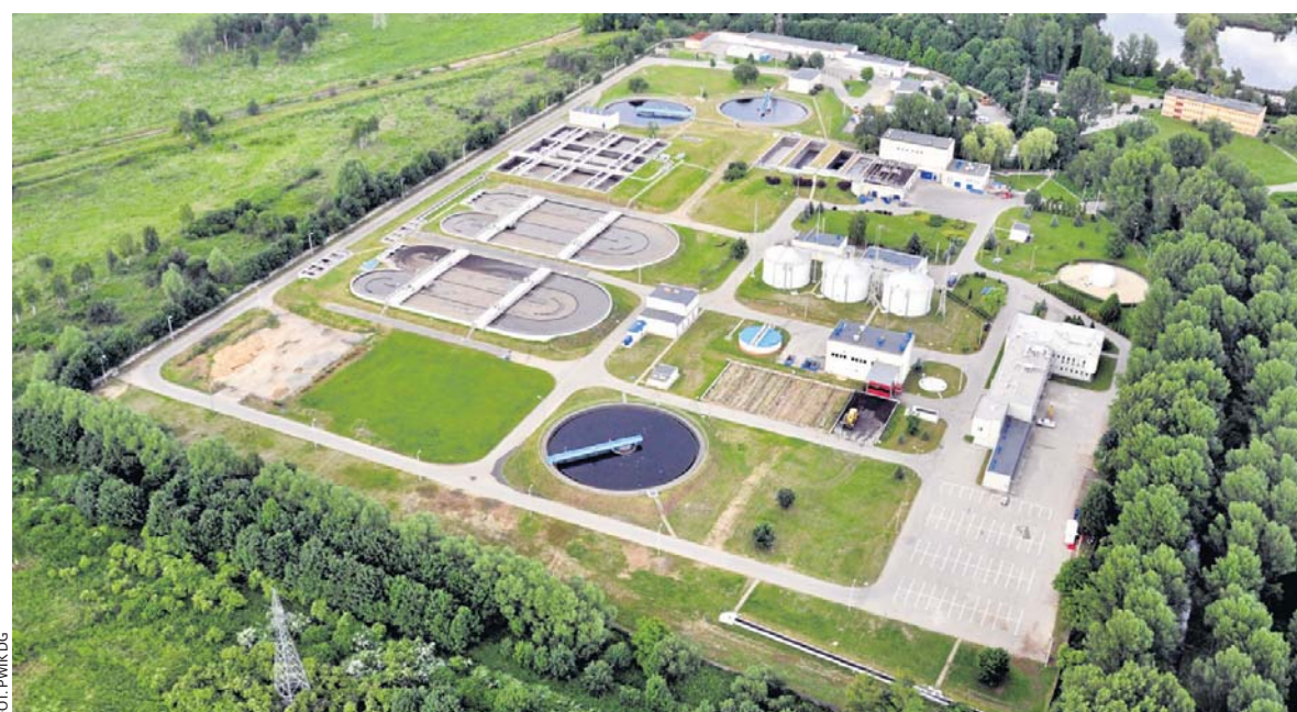
Tak wygląda nowoczesna oczyszczalnia w Dąbrowie Górniczej z lotu ptaka
